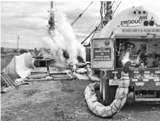
Hình 6. Ứng dụng đóng băng bằng cách bơm nitơ lỏng [8]
